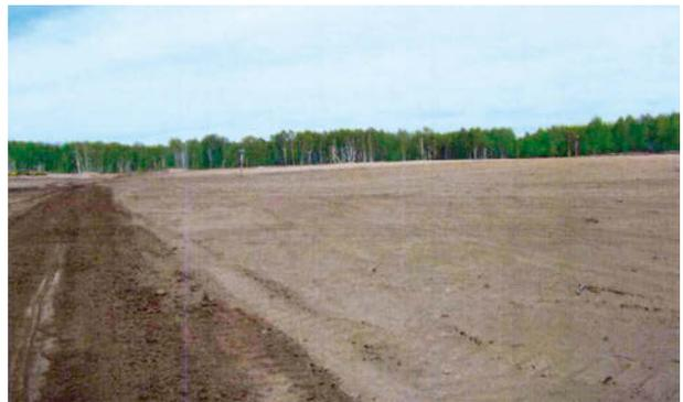
Рис. 10. Разборка дамб обвалования и планировка защитного слоя
