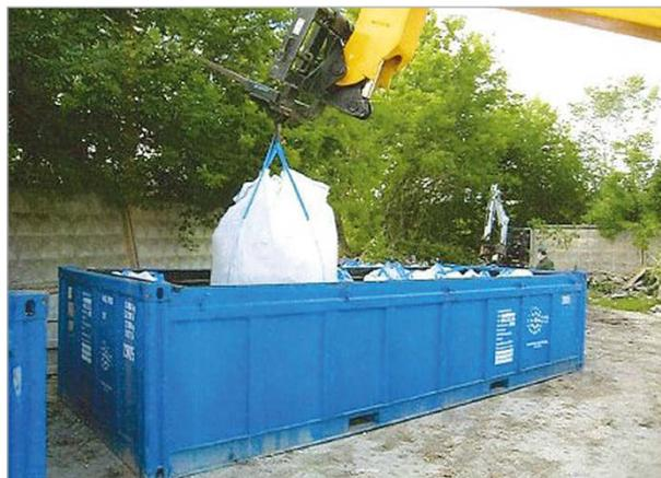
Рис. 7. Применение универсальной строительной техники для извлечения РАО и размещение первичных упаковок с РАО в контейнеры для транспортировки в специализированную организацию
