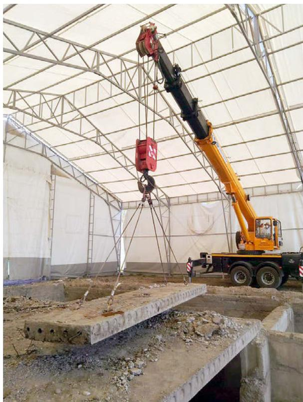
Рис. 4. Вскрытие плит перекрытия ХТО-2
