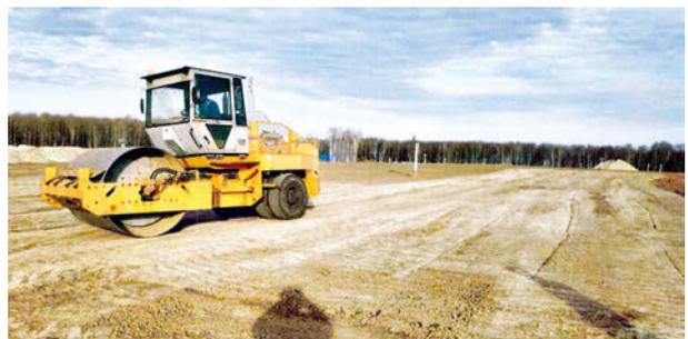
Рис. 11. Укладка и уплотнение глиняного экрана
